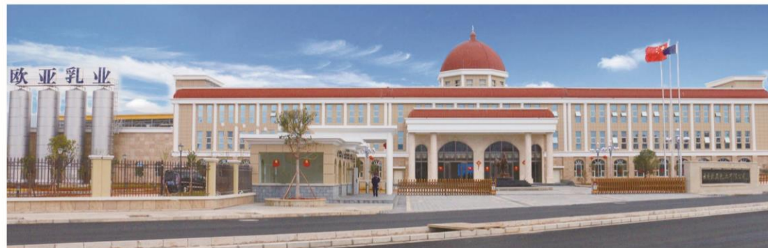
云南欧亚乳业有限公司三期工厂
